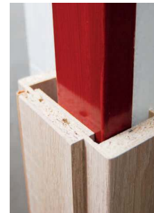
obklad ocelovej zárubne
